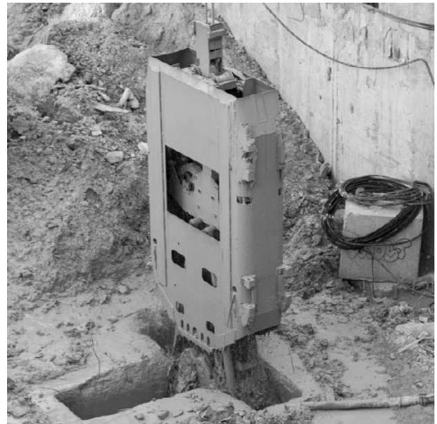
**Рис.3** Устройство Т-образной барреты способом «стена в грунте» навесным канатным грейфером
